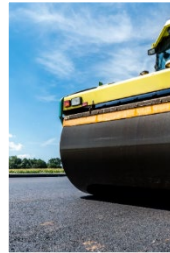
Road Paving Pavimentación de Carreteras
