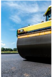
Road Paving Pavimentación de Carreteras
