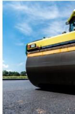
Road Paving Pavimentación de Carreteras
