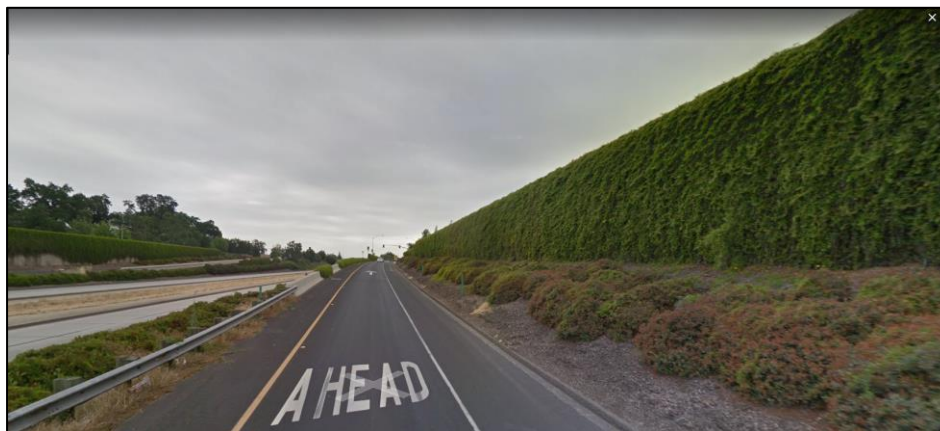
Figura 4-8 Barrera Vegetativa con Barrera Sólida en el Highway 198, Visalia, CA
