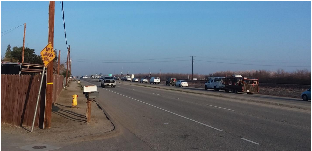
Figura 4 - Arcén Existente de la Autopista 43 Mirando al Norte
