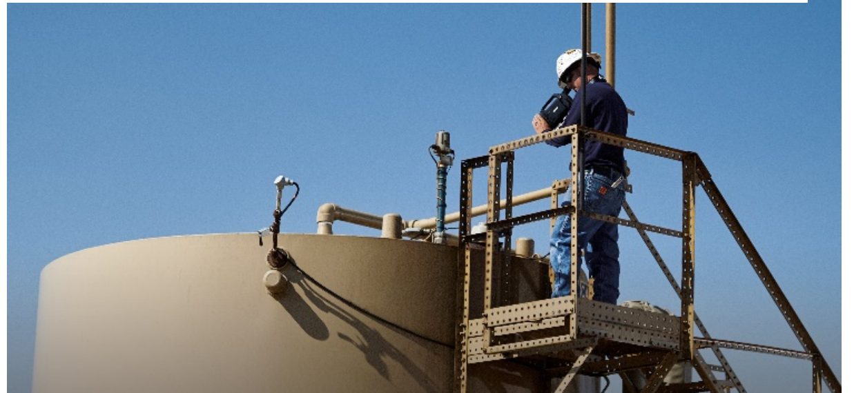
Inspección de Componentes de Tanque mediante Cámara OGI
