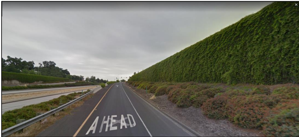
Figura 4-8: Barrera Vegetativa con Barrera Sólida en la Carretera 198, Visalia, CA*
