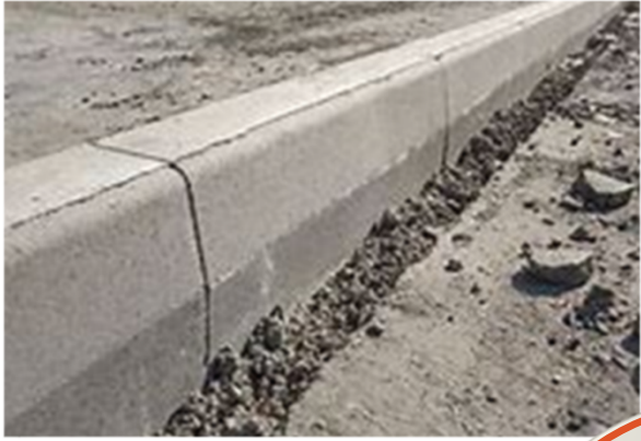
Curb and Gutter / Bordillo y canalón/alcantarilla
